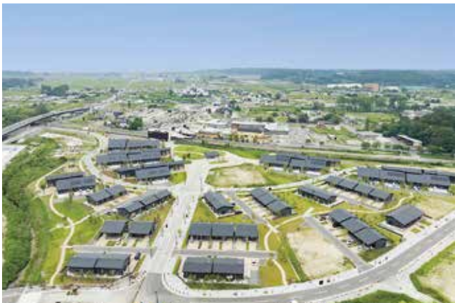
▲JR双葉駅（中央）周辺と西側に整備された公営住宅（下部）
